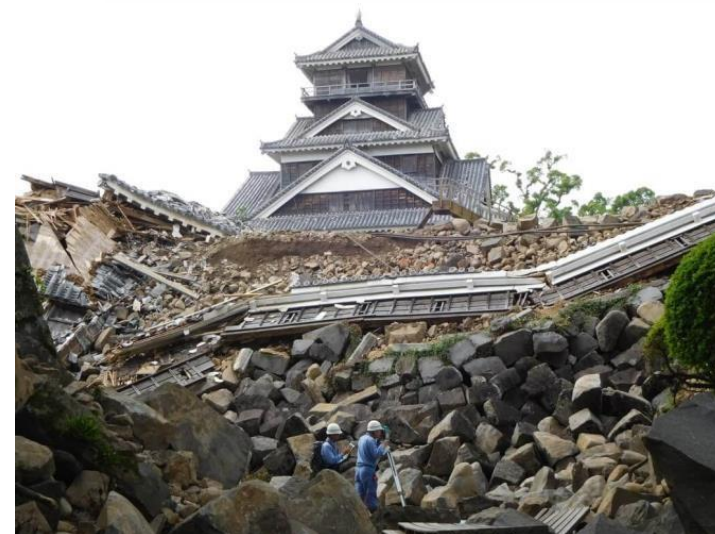
大きな被害を受けた熊本城
